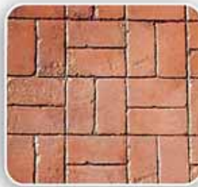
LADRILLO EN CESTERÍA
