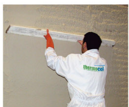
Aplicación sobre ladrillo y hormigón
